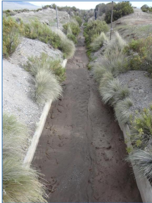
**Figura 3.** Canal de aducción (sin funcionamiento) con alta carga de material depositado.
