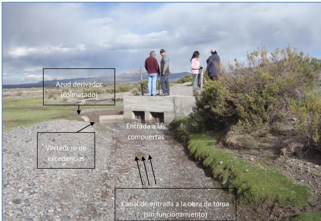
**Figura 1.** Obra de toma de derivación directa, con azud derivador. La obra se encuentra sin funcionamiento, aparentemente debido a la incorrecta orientación del azud derivador (fuera del eje del curso natural del Río Sajama, ver Figura 2) y la alta carga de material fino depositado (ver Figura 3).
