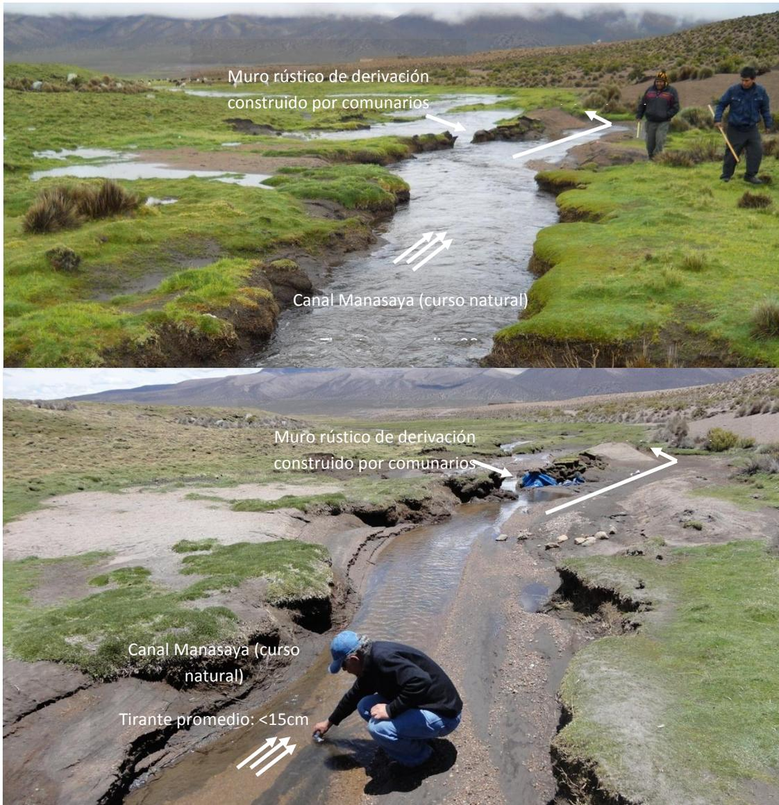
**Figura 4.** Sitio de emplazamiento sugerido. Abajo: Fotografía tomada en diciembre de 2011, al inicio de la época de lluvias. Arriba: Fotografía tomada en febrero de 2012, durante la época de lluvias. Nótese la diferencia en caudales entre ambas fechas, la carga de material, el rápido cambio en la cobertura vegetal y la inestabilidad en las paredes del canal natural Manasaya.
