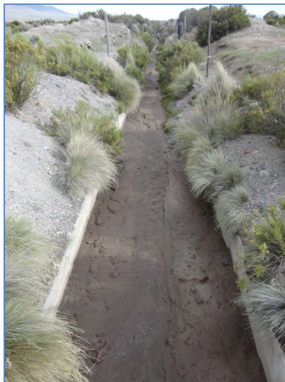
Figura 11. Canal de aducción (sin funcionamiento) con material de suspensión.
