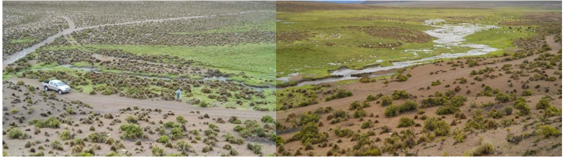
Figura 17. Vista panorámica del sitio de emplazamiento de la obra de toma; canal (natural) Manasaya.
