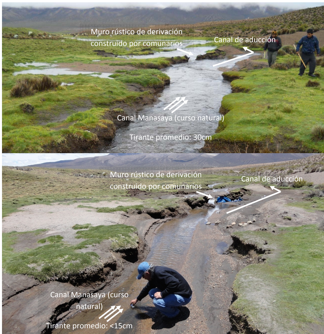
Figura 12. Sitio de emplazamiento. Abajo: Fotografía tomada en Diciembre de 2011 (inicio de la época de lluvias). Arriba: Fotografía tomada en Febrero de 2012 (época de lluvias). Nótese la diferencia en caudales entre ambas fechas, la carga de material, el rápido cambio en la cobertura vegetal y la consecuente inestabilidad en las paredes del canal natural Manasaya.
