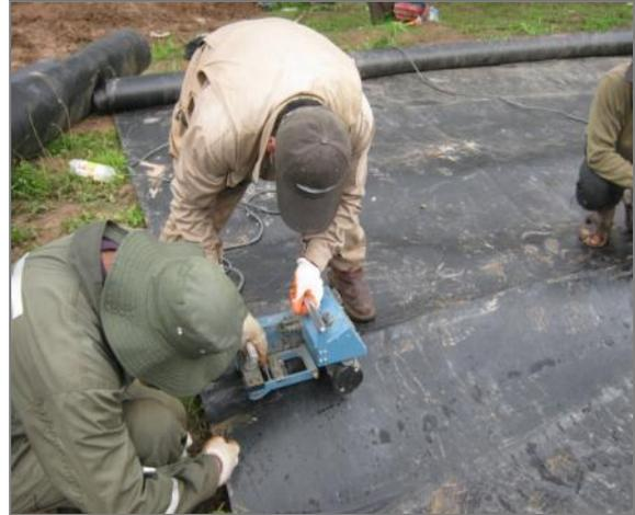
**Figura 30.** Soldadura de extrusión (E. Torrez)
