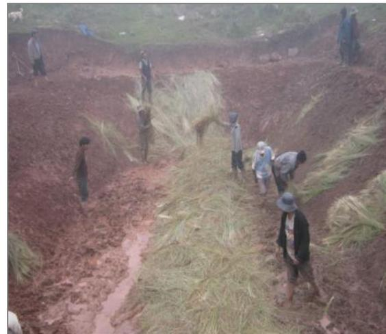
**Figura 26.** Preparación final del sitio, para el revestimiento con geomembrana (E. Torrez)
