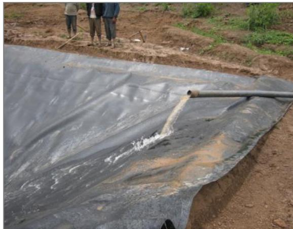
**Figura 36.** Construcción de la camara de carga (E. Torrez)
