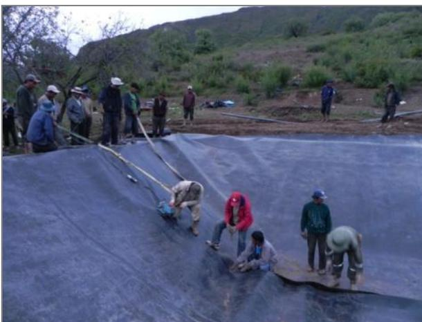
**Figura 33.** Soldadura de (D. Salazar y E. Torrez)
