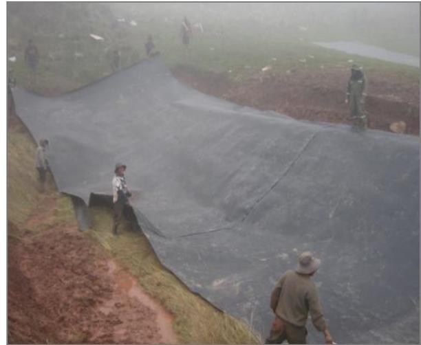
**Figura 27.** Revestido del atajado con Geomembrana HDPE. (E. Torrez)
