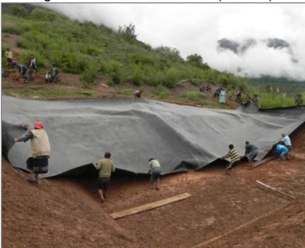
**Figura 31.** Revestido del atajado con la Geomembrana (E. Torrez)
