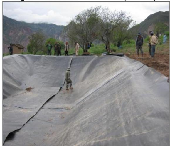
**Figura 32.** Revestido del atajado con la Geomembrana (E. Torrez)
