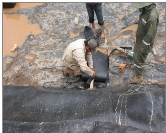
**Figura 34.** Armado y sellado del desfogue de agua (D. Salazar y E. Torrez)
