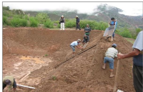
**Figura 22.** Nivelación de los taludes en La Granja (E. Torrez)
