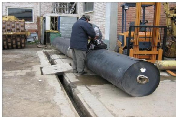
**Figura 23.** Rollo de Geomembrana (7m\*200m) (E. Torrez)
