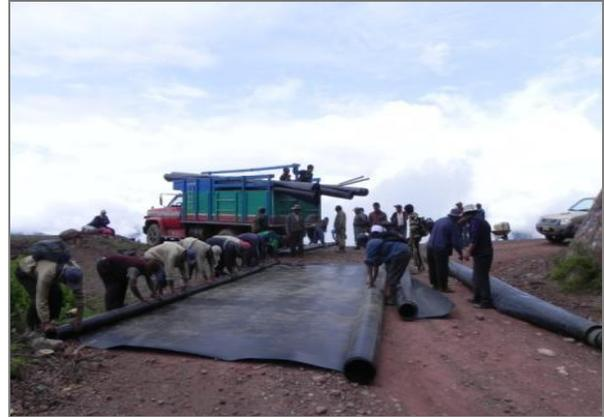
**Figura 25.** Enrollado de la geomembrana para su transporte hasta el lugar de emplazamiento (E. Torrez)
