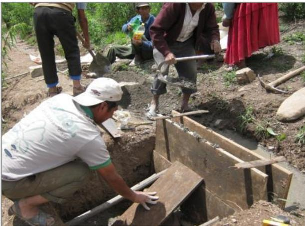
**Figura 35.** Construcción de vertedor y desarenador (E. Torrez)
