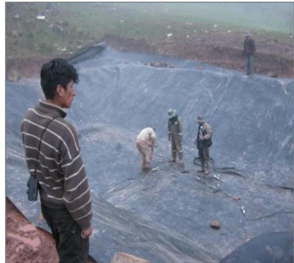
**Figura 28.** Soldadura de extrusión y seguridad en Atajado (E. Torrez)
