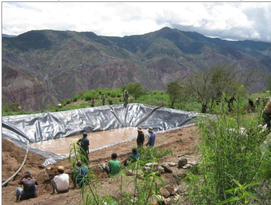
**Figura 37.** Vista panoramica del Atajado ubicado en La Granja revestido con geomembrana (E. Torrez)
