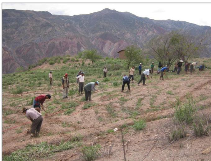
**Figura 18.** Replanteo y marcado del atajado de la comunidad La Granja (E. Torrez)
