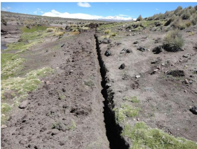
EXCAVACIÓN LISTA PARA LA INSTALACIÓN DE LA TUBERÍA
