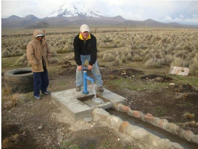
UNA DE LAS BOMBAS INSTALADAS CON UN CANAL CONDUCTOR, CONSTRUIDO POR EL COMUNARIO
