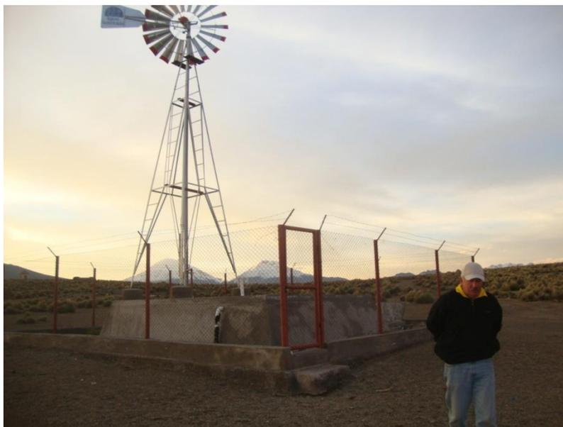
AEROBOMBA INSTALADA SOBRE EL TANQUE DE ALMACENAMIENTO DE AGUA
