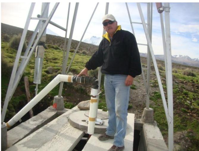
TUBERÍA DE IMPULSIÓN FORRADA CON TECNOPOR PARA EVITAR EL CONGELAMIENTO
