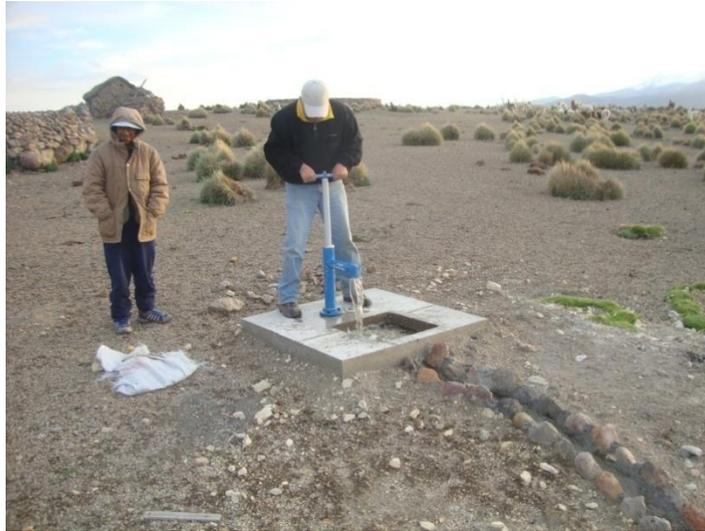
OTRA DE LAS BOMBAS INSTALADAS CON CANAL CONDUCTOR
