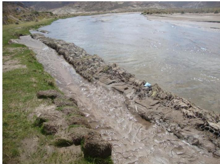
ESTADO DEL PRIMER TRAMO DESPUES DE LAS CRECIDAS, RETUBO LA INUNDACIÓN
