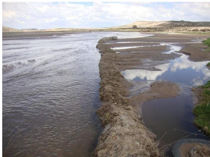
TERCER TRAMO DESPUES DE LAS CRECIDAS, SE PUEDE APRECIAR LA INCLINACIÓN DE LOS GAVIONES
