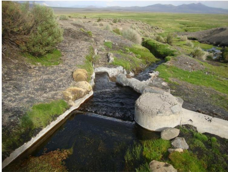
TOMA CONSTRUIDA SOBRE UNA ESTRUCTURA EXISTENTE (IZQUIERDA)
