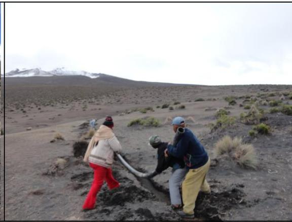
**Foto 7-8. Descarga de materiales, excavación e instalación de tuberías en la comunidad Papelapampa.**
