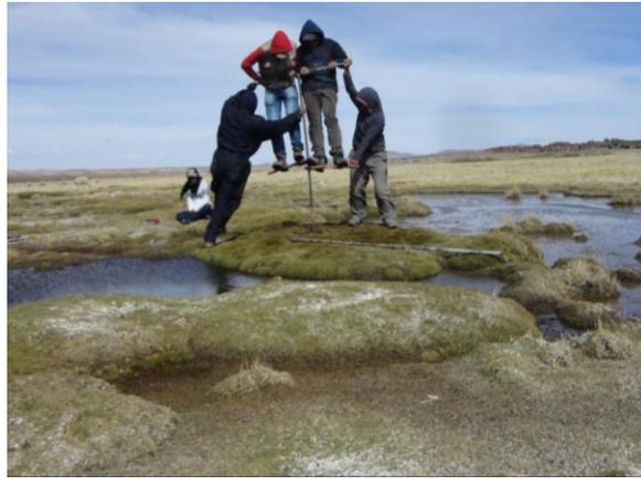
Fotografía 15. Perforación para instalación de piezómetros.
